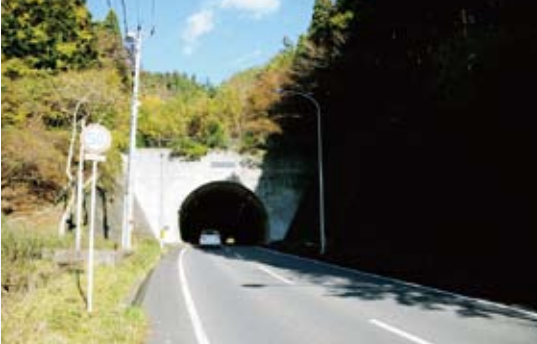
【新小積トンネル】小積浜から小網倉浜に至る小積峠をショートカットするためにつくられた新小積トンネルは、1988年3月に完成した。延長470mのトンネルによって、それまで細く曲がりくねった山道を通ることなく、旧石巻市と旧牡鹿町をスムーズに往来できるようになった。
